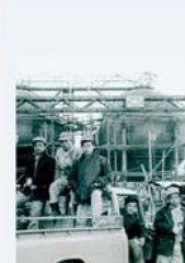
LPガスプラントの配管工事から総合施工に進出
